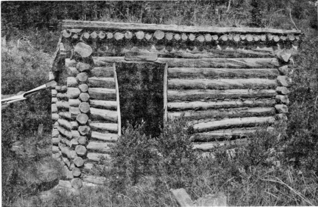
2 Latrine pour trois personnes, site 10Y2.
