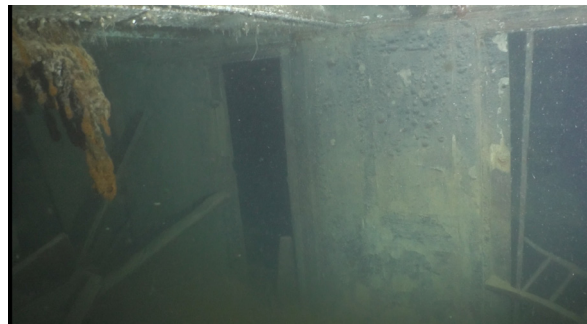
Figure 4.2.21 : Portes des cabines S6 et S7 vues du centre du carré des officiers (vidéo : R. Harris, Parcs Canada; 90M2802EF).
