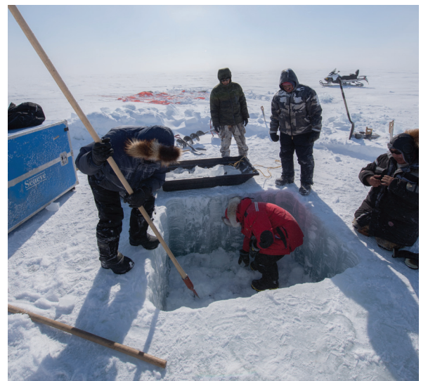
Figure 3.2.2 : Excavation du trou d'accès pour le VTG à travers l'épaisse glace de mer (photo : T. Boyer, Parcs Canada; 90Moo6o6EF).
