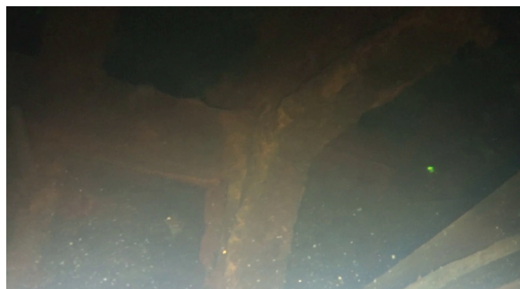
Figure 5.4.1 : Dessous du pont inférieur tel que vu de la « soute à pain » dans le faux-pont (Arrêt sur image : R. Harris, Parcs Canada; 89M2016R003_12628).
