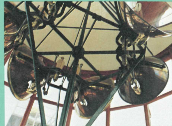
Mécanisme de réflexion typique (cap Bonavista) Typical reflector light (Bonavista)
