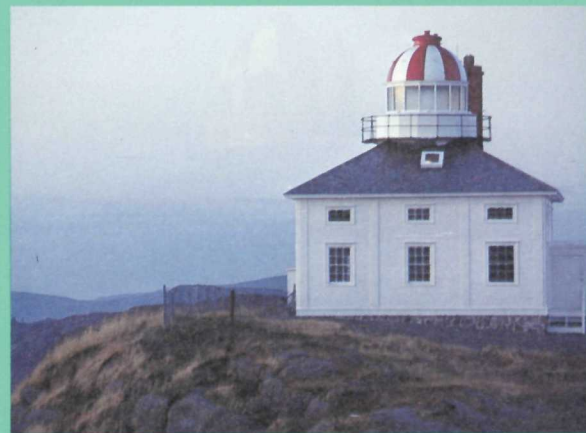
Le phare en 1835, après sa restauration. Restored 1835 lighthouse.
