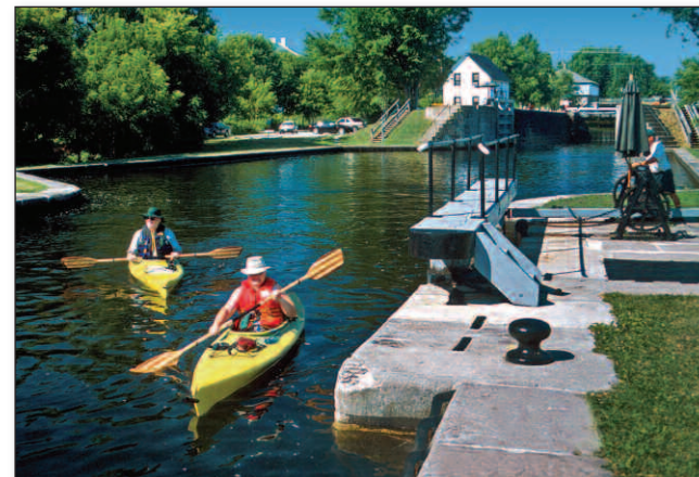
Poste d'éclusage de Merrickville Merrickville Lockstation
