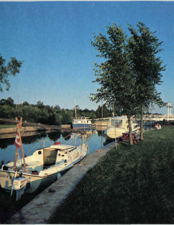
Kilmarnock Lock / Écluse de Kilmarnock
