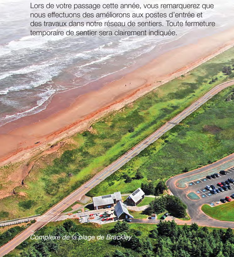
Poste d'accueil au terrain de camping de Cavendish
