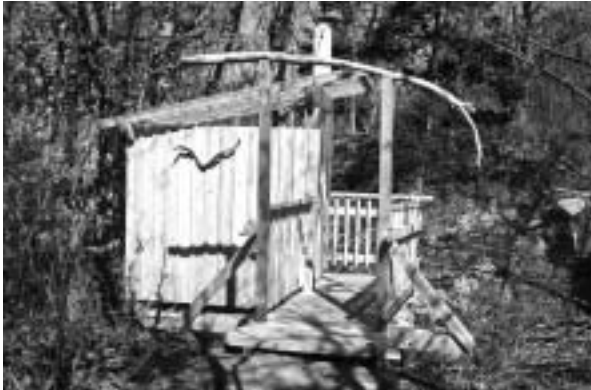
On continue à installer de nouvelles toilettes à compostage dans les îles du parc. Avant la fin de 2009, on compte remplacer toutes les anciennes latrines par ces nouvelles toilettes, bonnes pour l'environnement.
