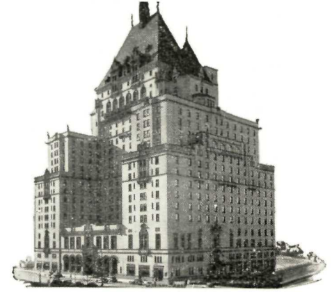
Hotel Vancouver, Vancouver, B.C.
