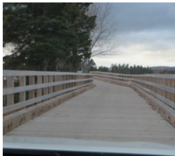
La nouvelle passerelle/route de Penouille, a été construite sur pilotis, afin qu'elle résiste aux inondations
