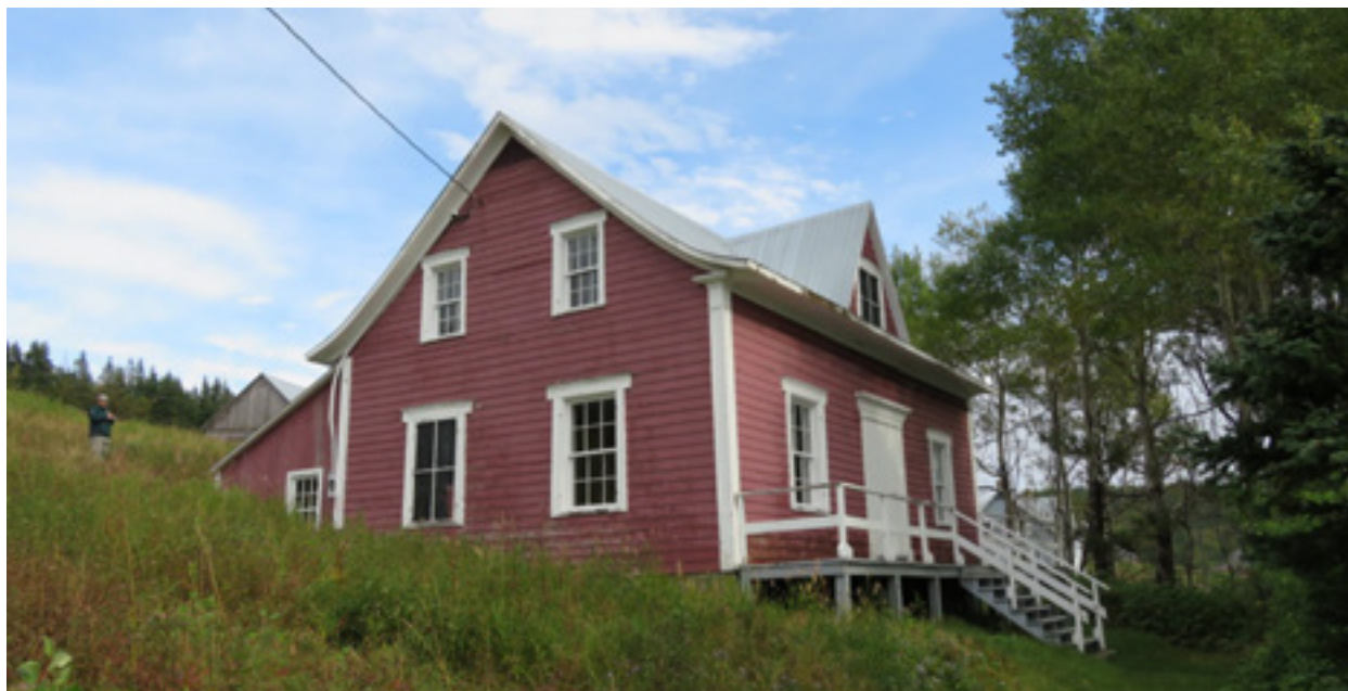
Les volumes d'eau de surface et d'eau souterraine qui s'écoulent vers la baie doivent être bien gérés autour des édifices et des sites patrimoniaux, surtout lorsque ces structures sont vacantes ou non utilisées.
