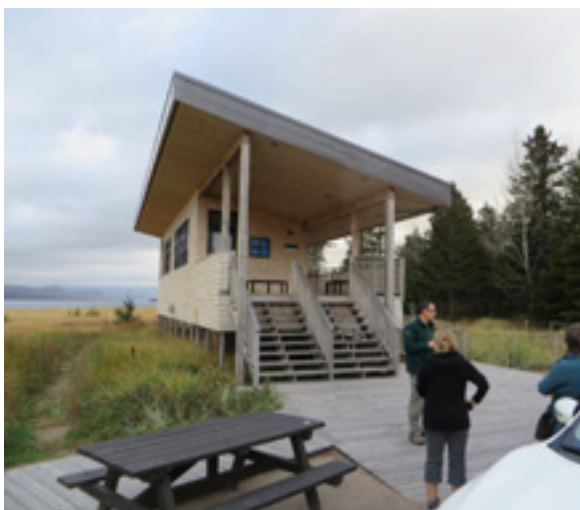
Le nouveau bâtiment a été construit sur pilotis et a été éloigné de la rive afin qu'il puisse résister aux ondes de tempête et aux inondations
