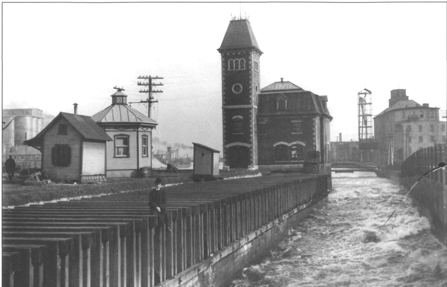
La centrale hydroélectrique de Côte-Saint-Paul, 1905. Archives nationales du Canada (C-063600). Côte-Saint-Paul hydro-electric station, 1905. National Archives of Canada (C-063600).
