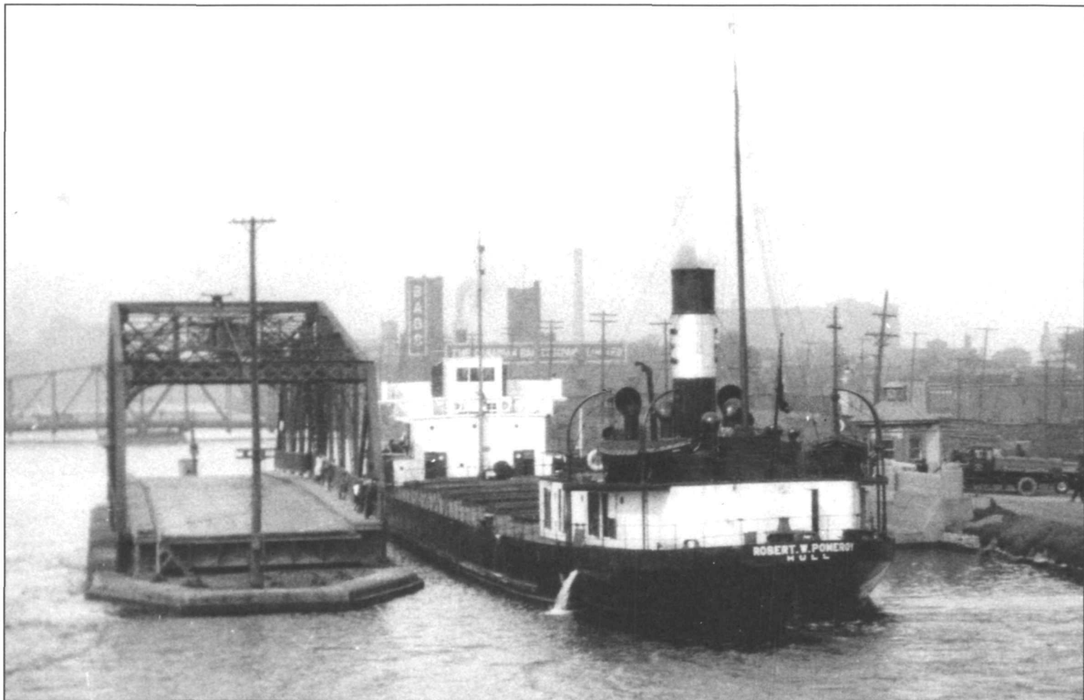
Le pont n° 5, rue Atwater, date non précisée (vers 1925). Archives nationales du Canada (PA202366). Bridge No. 5, Atwater Street, date not specified (circa 1925). National Archives of Canada (PA202366).
