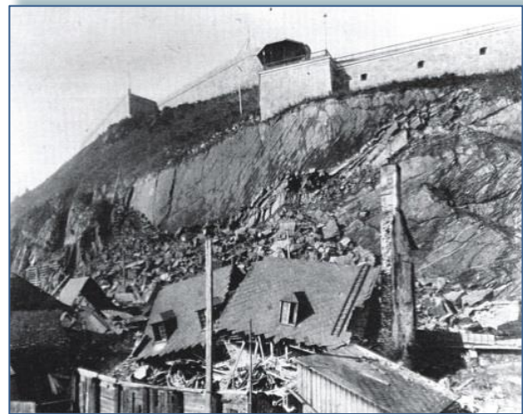
Figure 55 : Glissement de terrain du 19 septembre 1889 au Cap Diamant (photographie gracieuseté de la Société historique de Québec)
