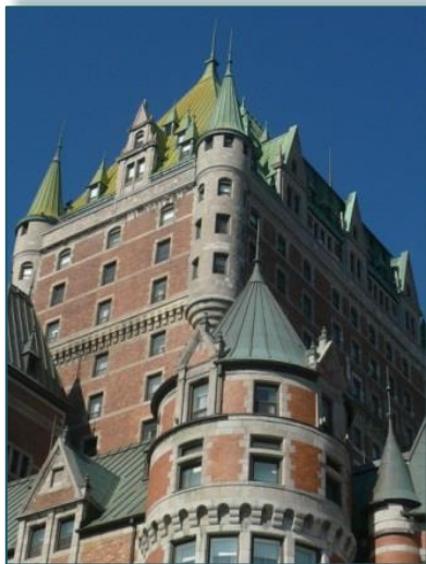
Figure 30 : Château Frontenac (photographie de Jean-François Bureau, Commission géologique du Canada, 2007)
