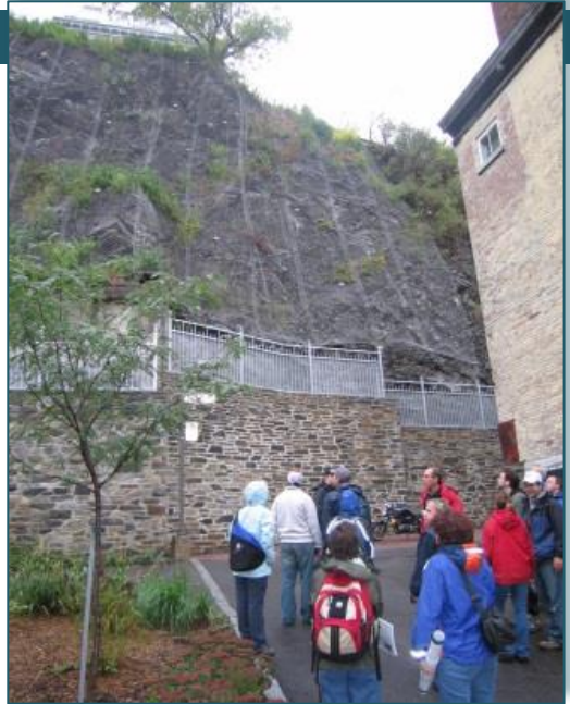
Figure 45 : Mur de soutènement et pose d'ancrage sur la rue Sault-au-Matelot (photographie de Léopold Nadeau, Commission géologique du Canada, 2003)
